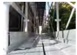
本足場の使用例
