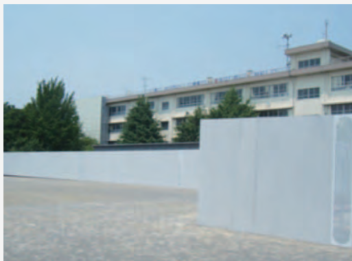
学校耐震補強工事
