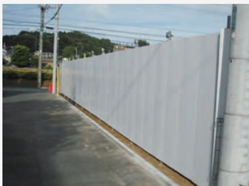
新設工事仮囲い
