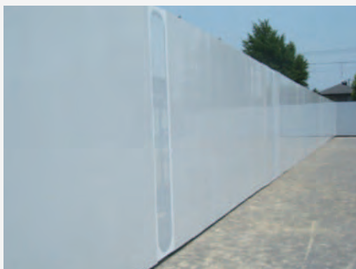
改修工事仮囲い
