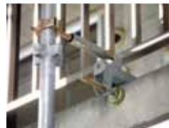
アンカーブラケット施工
