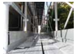
本足場の使用例
